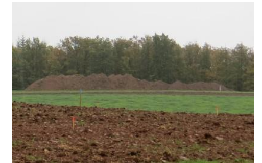
Figure 7 : Terre végétale stockée sur un chantier de centrale photovoltaïque (Source : Abies, suivi de chantier)
